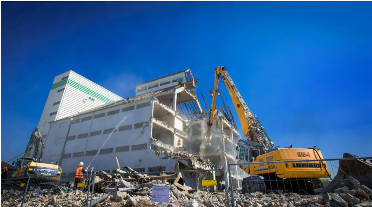
Abb. 18: Selektiver Rückbau, Abbruch der mineralischen Grundsubstanz nach Entkernung und Schadstoffentfrachtung (© Scherer & Kohl GmbH)
