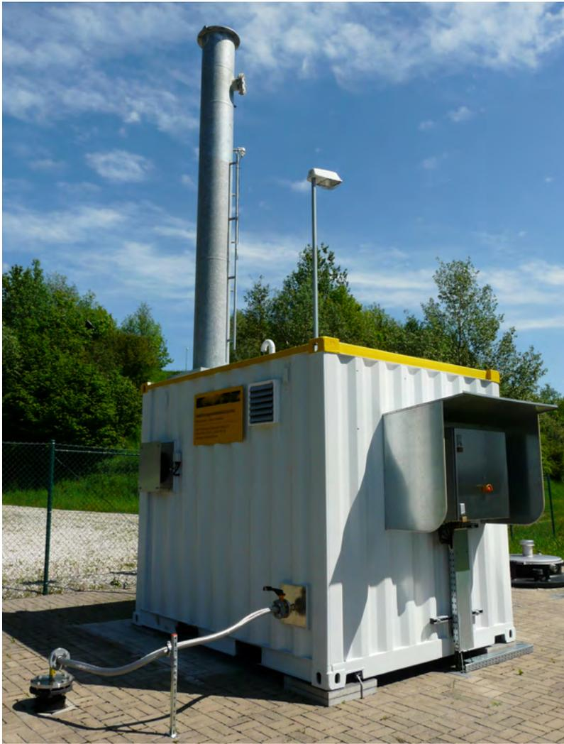
**Abb. 22: Schwachgasfackel zur Beseitigung von Deponiegas mit geringem Methangehalt (© LfU)**
