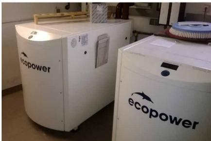
Die Industriespülmaschine wurde ursprünglich mit kaltem Wasser versorgt, welches elektrisch aufgeheizt wurde. Das Hotel verfügt jedoch über ein BHKW mit dessen Abwärme das Wasser aufgeheizt werden kann.
