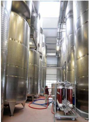
Die während der Erntezeit zusätzlich benötigte Kälte wird mit gemieteten Kompakt-Kaltwassersätzen erzeugt. Diese Kompakteinheiten sind jeweils mit mehreren Kompressoren, einem luftgekühlten Kondensator und einem Verdampfer ausgerüstet. Sowohl energie- wie auch kostenmäßig ist es günstiger, alle Kaltwassersätze auch bei niedriger Last im Parallelbetrieb zu fahren, da so der Zeitanteil bei
