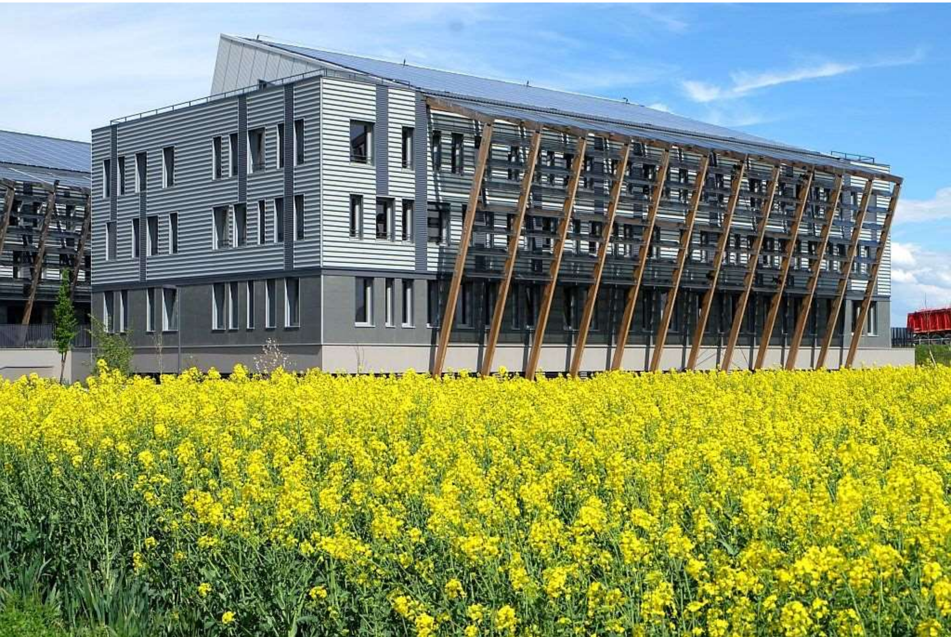
Jonage, Région Lyon, Bürokomplex
