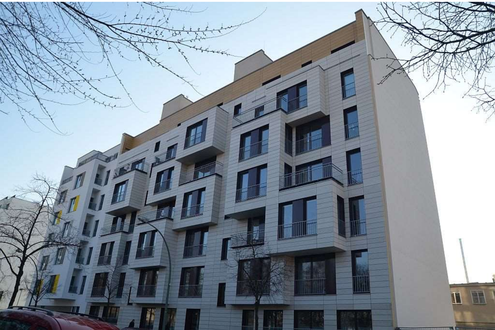
Berlin, Plusenergiegebäude Boyenstrasse, Betonskelett mit elementierter Holzfassade
