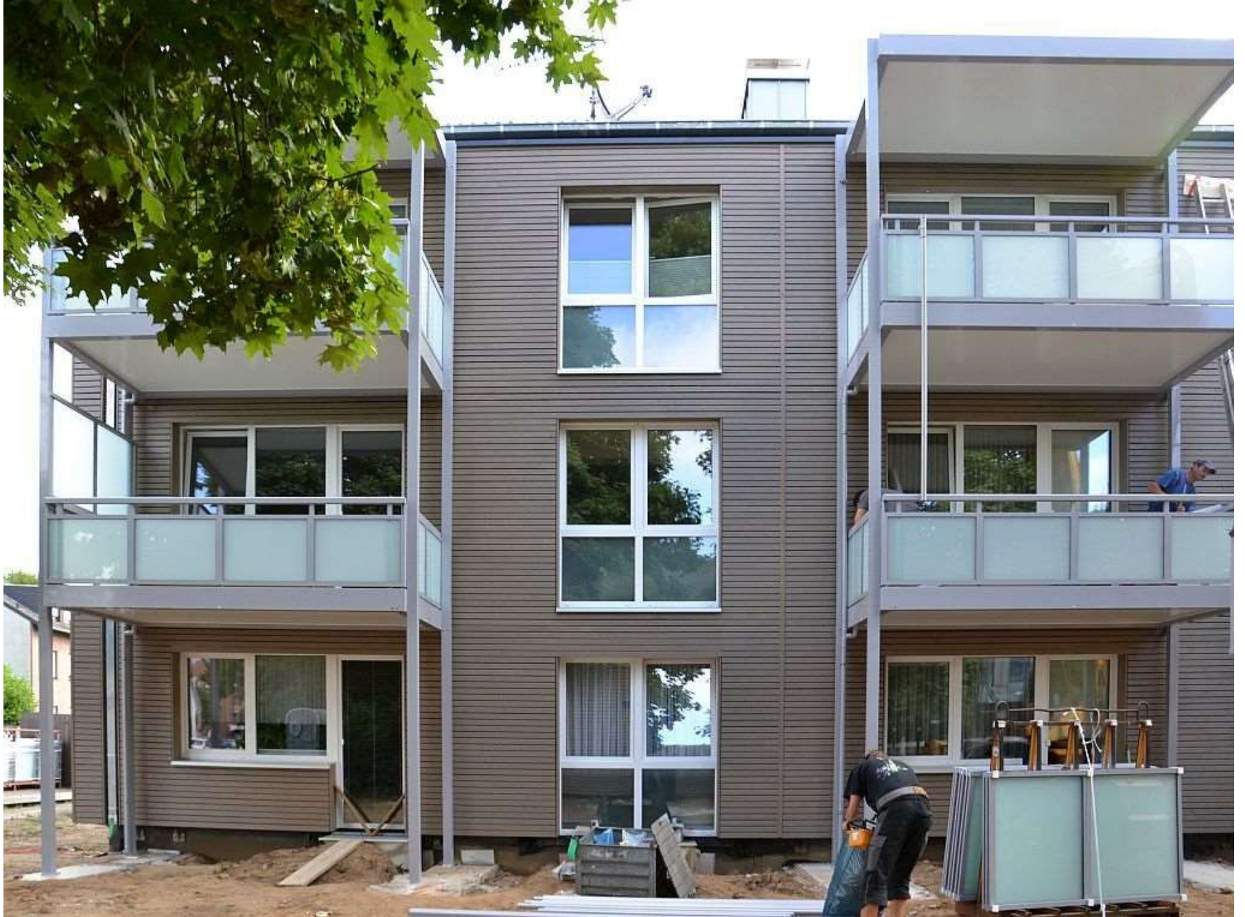
Duisburg, Erneuerung Wohnanlage
