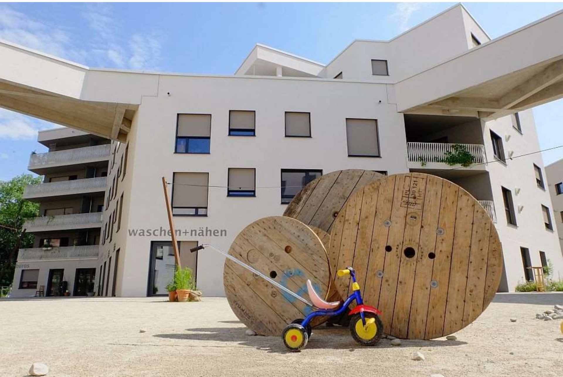
München, Domagkpark, Wohnanlage WagnisArt, deutscher Architekturpreis 2017
