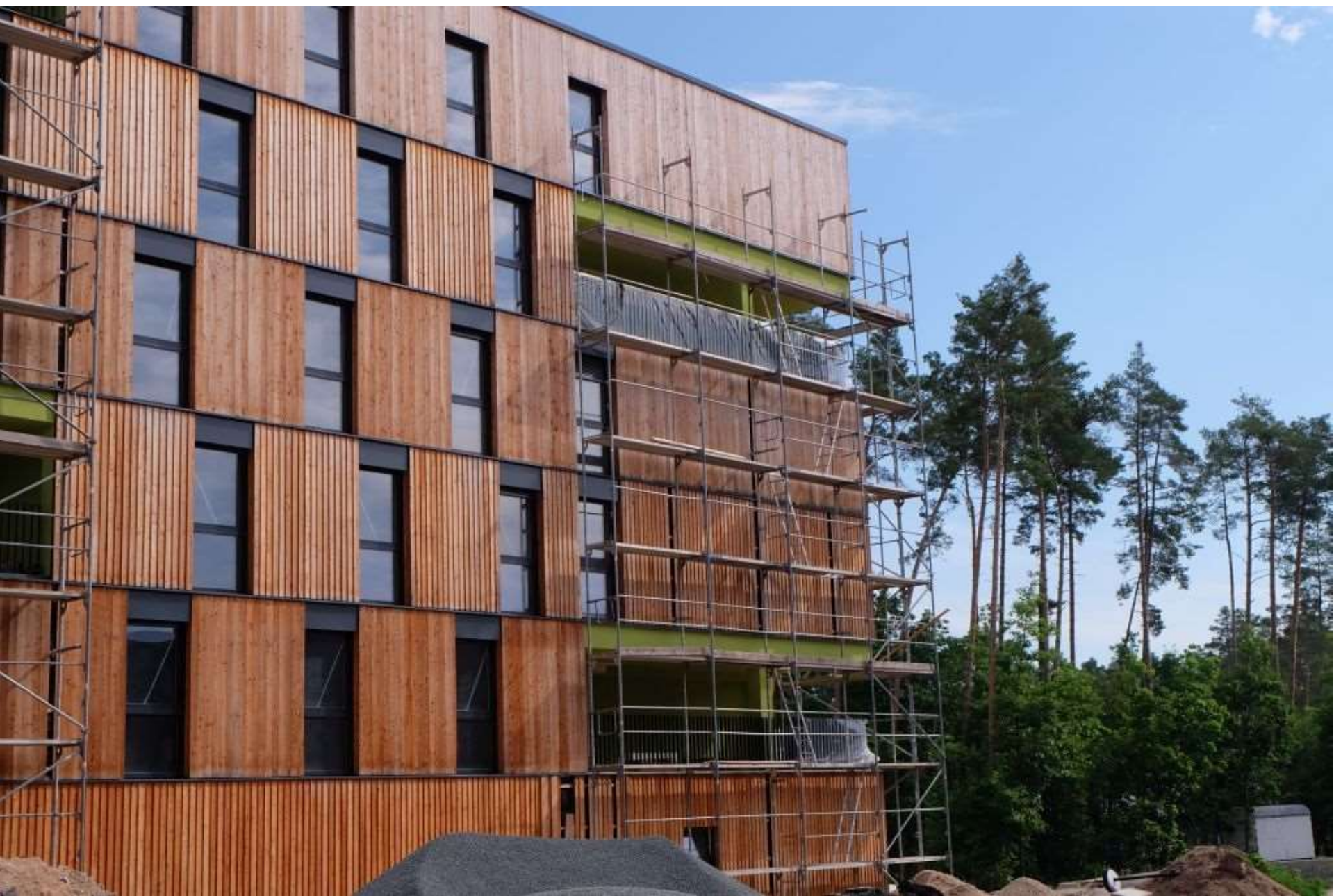
Erlangen, Studentenwohnheim, 400 neue Appartements, Betonskelett und Holzfassaden
