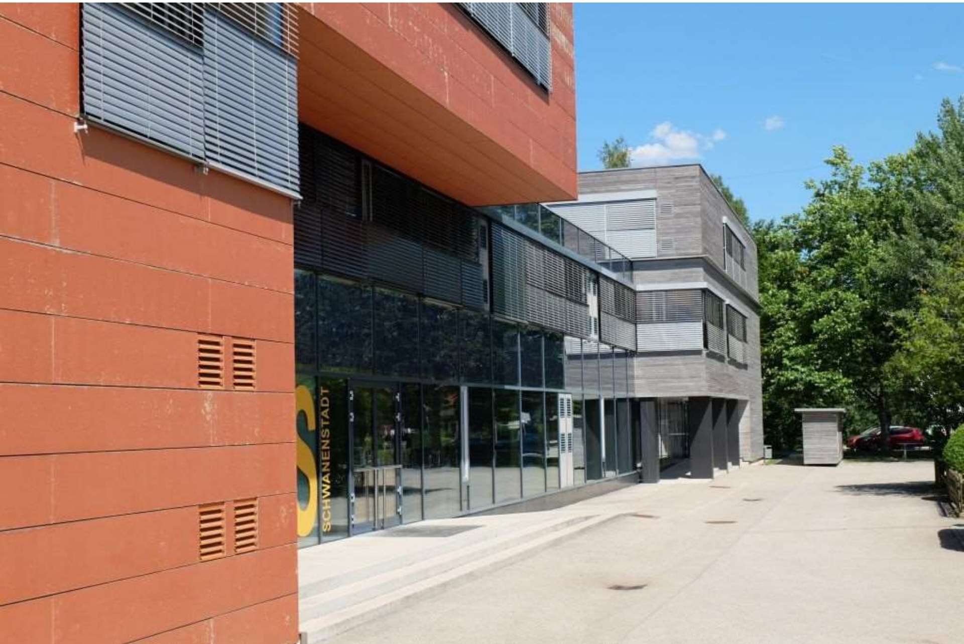
Schwanenstadt, saniert im laufenden Betrieb auf Passivhausniveau, 90% geringerer Energiebedarf
