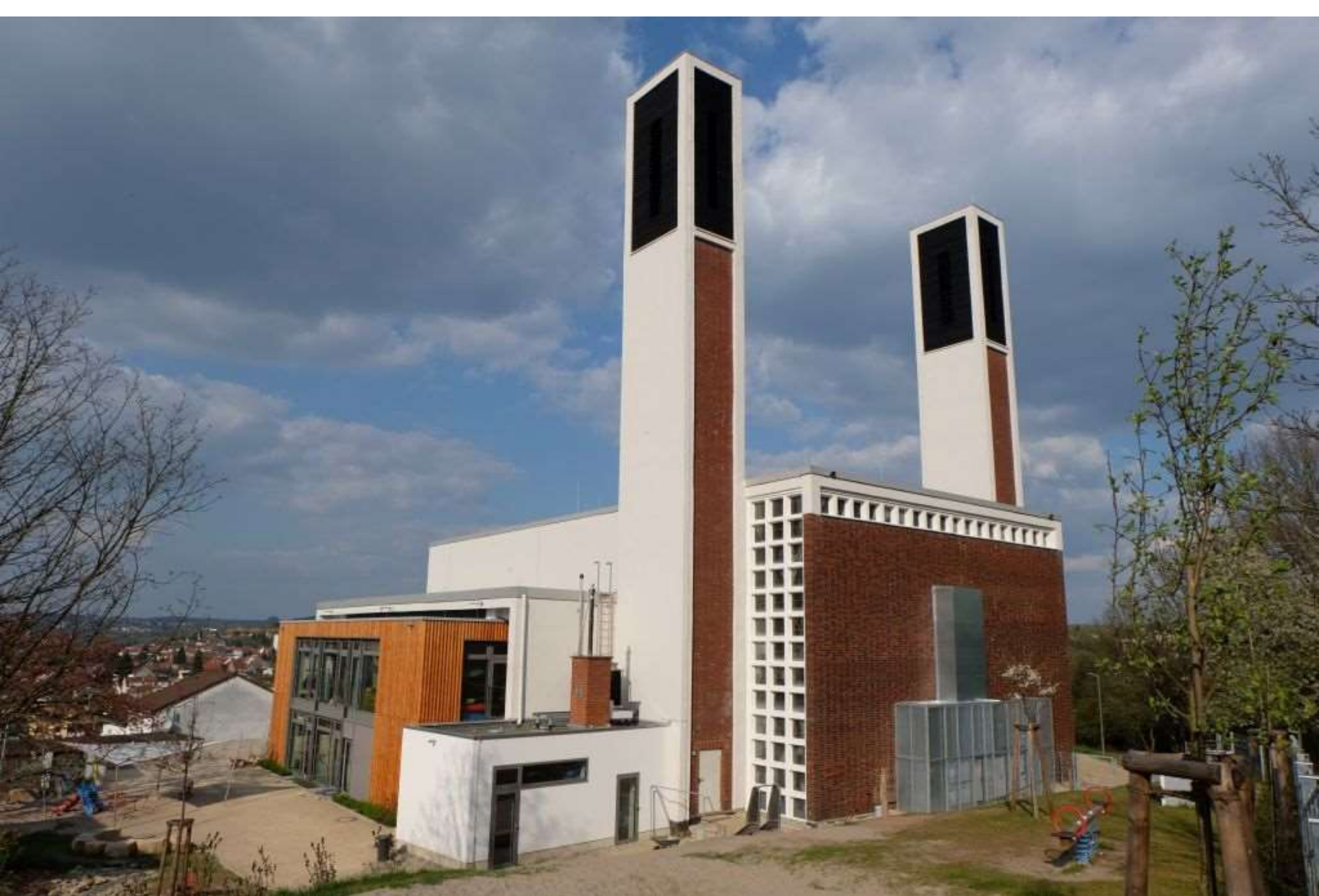
Saarbrücken-Dudweiler, Erneuerung/Umnutzung denkmalgeschützte Kirche
