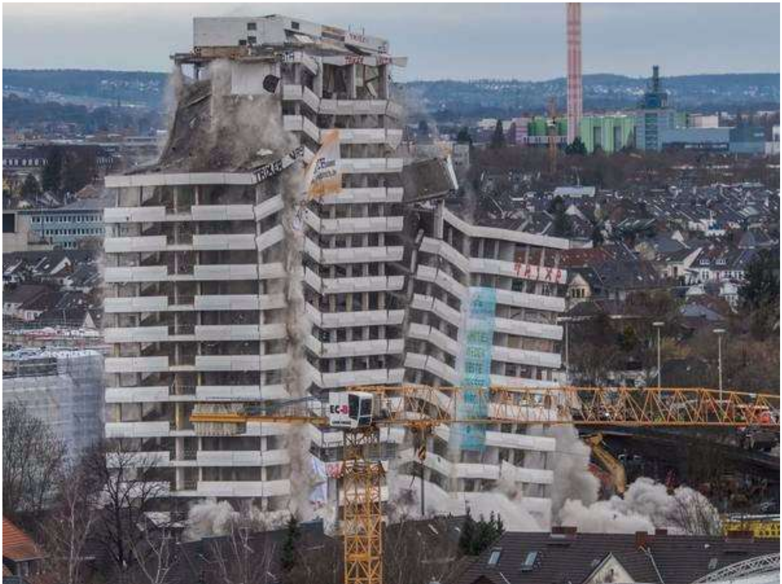
Bonn-Center: Nach 48 Jahren Umwandlung in 35.000 Tonnen Bauschutt
