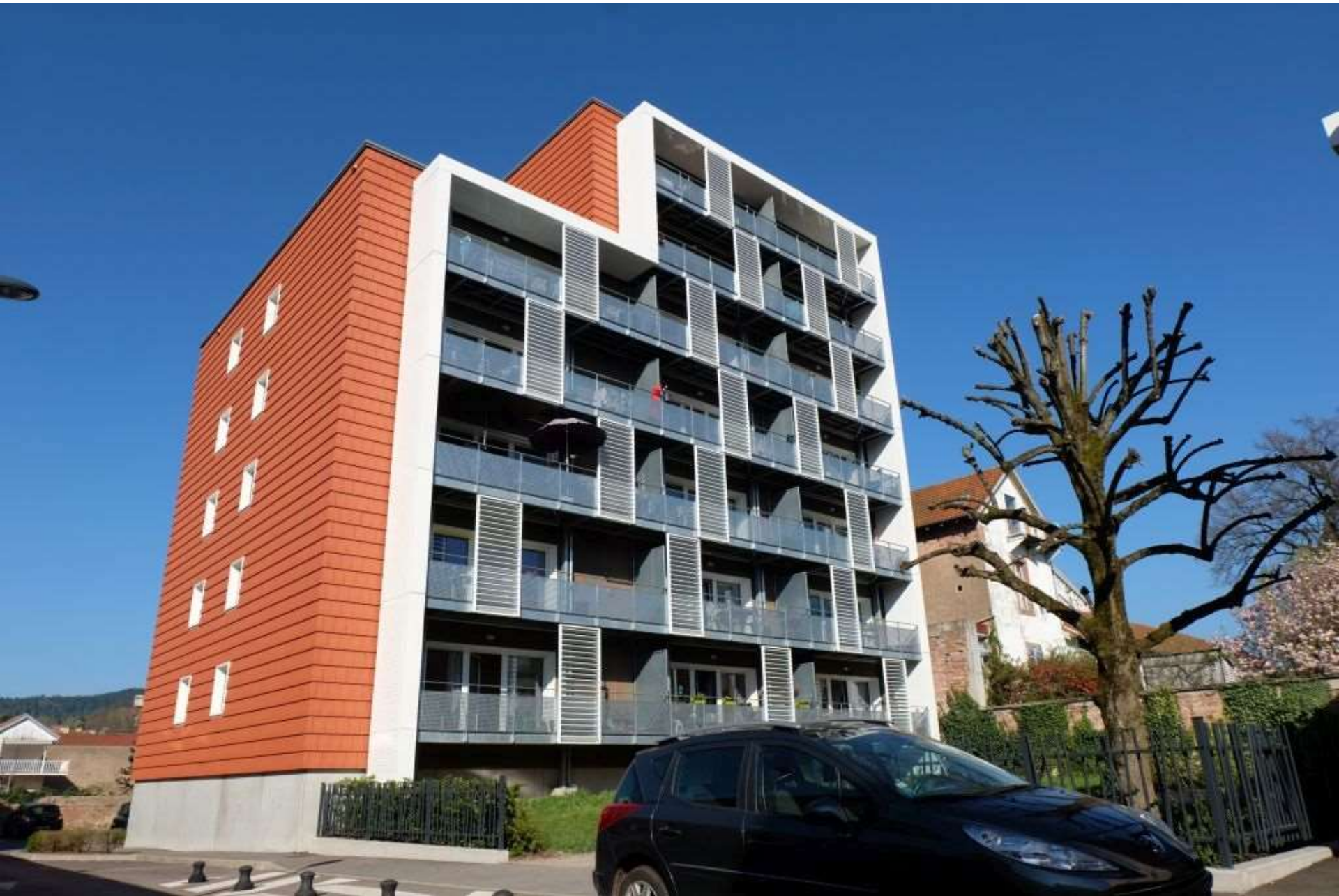
Saint-Dié des Vosges, Wohnanlage mit Strohballendämmung
