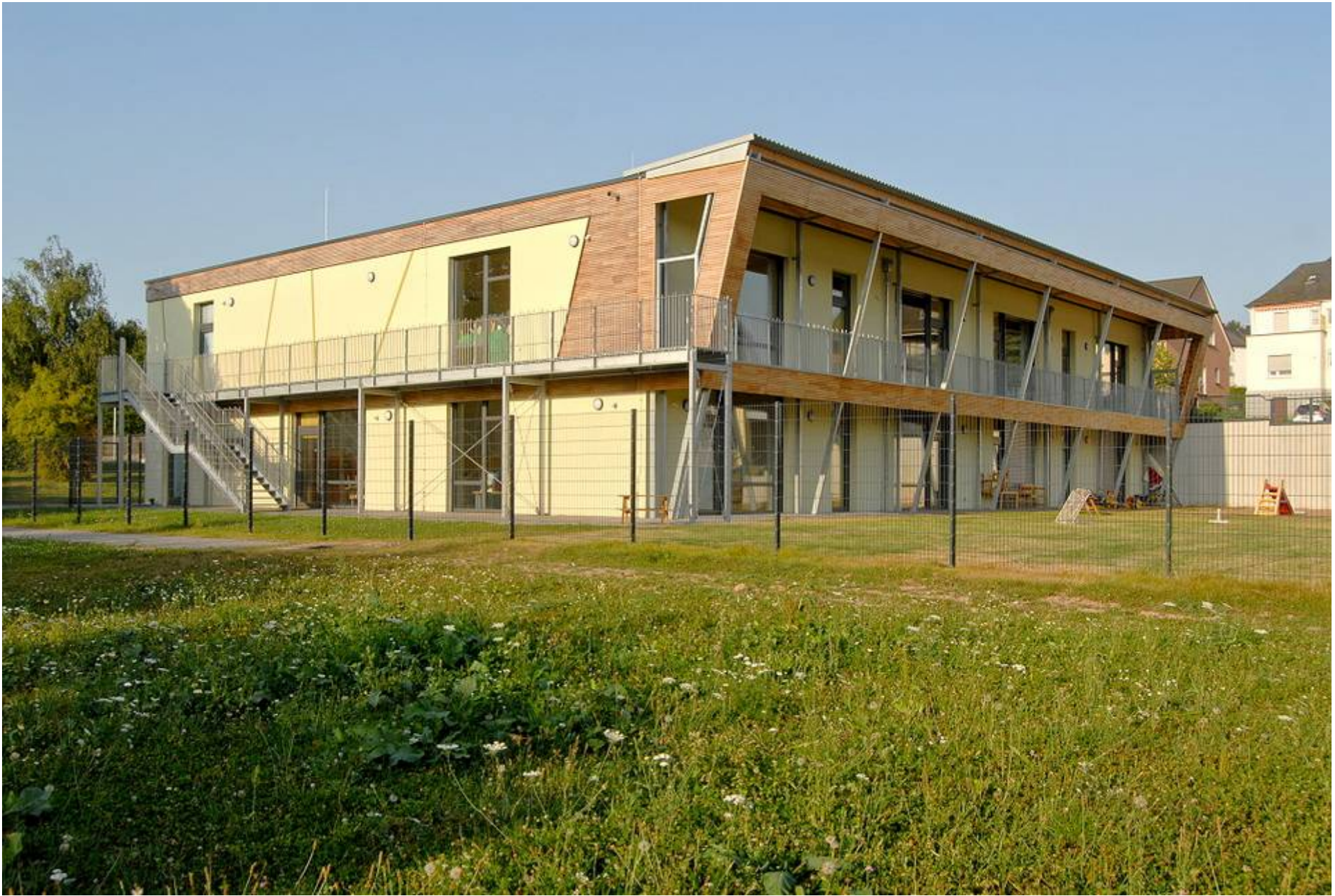
Passivhaus-Kindergarten in Saarburg
