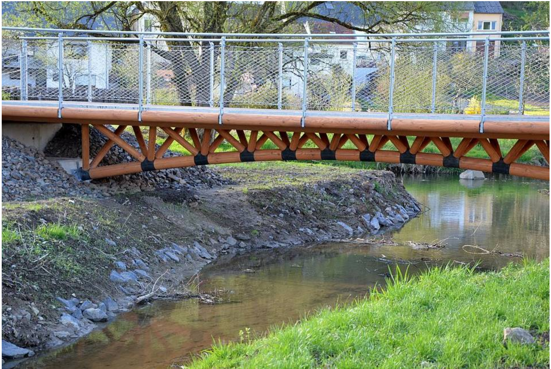
Brücke in Schönecken in Rundholzbauweise mit Knoten aus Beton
