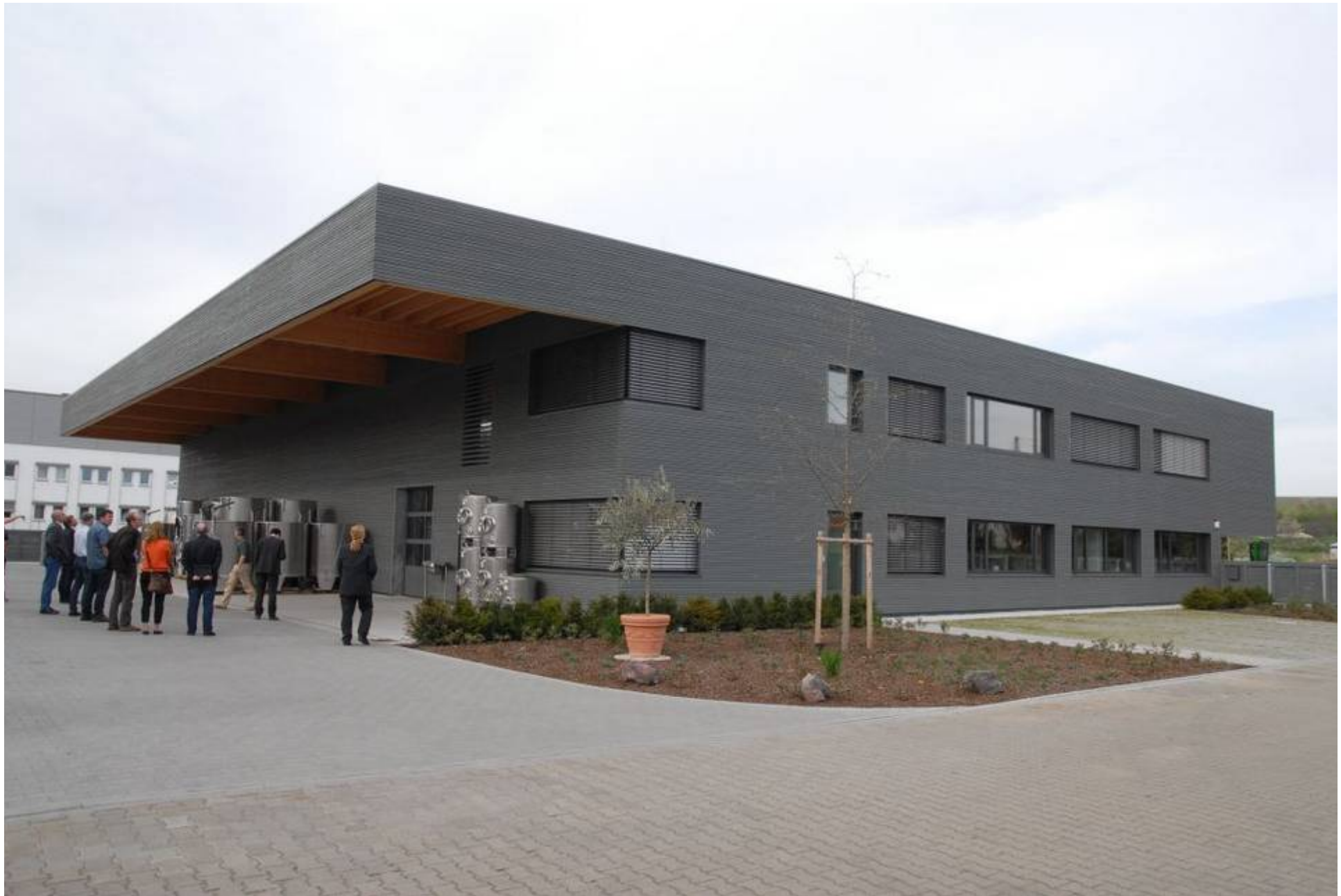
Gewerbegebäude in Alzey
