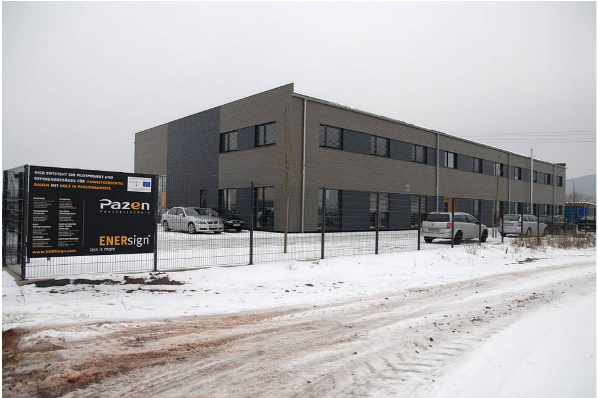
Plusenergie-Gewerbegebäude in Wittlich
