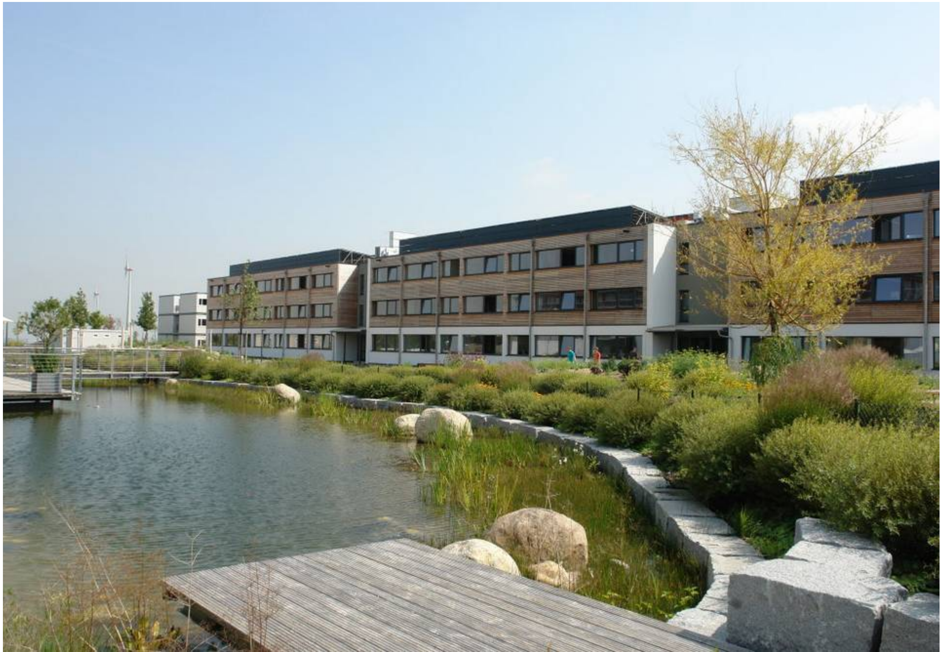
Firmenzentrale JuWi, Würzburg
